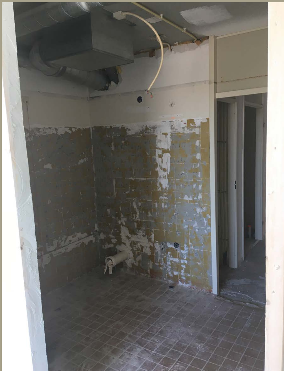
Sloopwerk badkamers, wanden en plafonds, bestaande tegelvloer dient als ondergrond voor epoxy troffelvloer.
