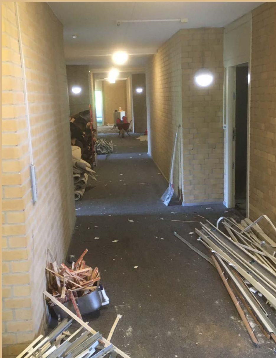
Sloopwerkzaamheden in de appartementen.
