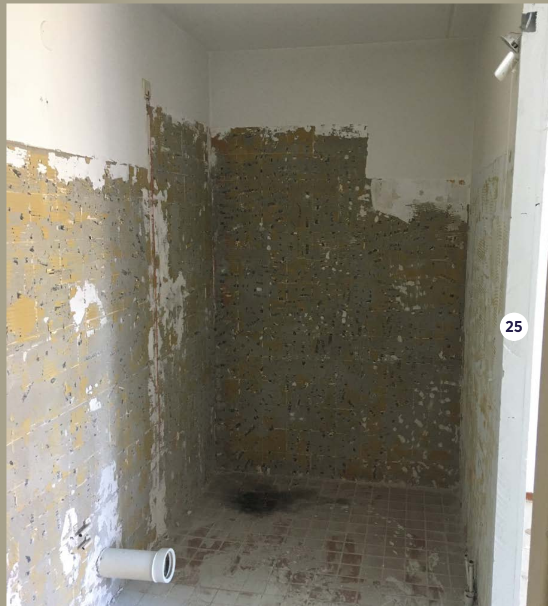
Sloopwerk badkamers, wanden en plafonds, bestaande tegelvloer dient als ondergrond voor epoxy troffelvloer.
