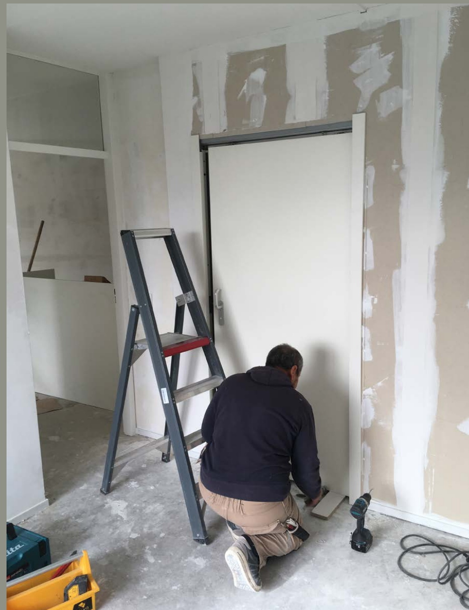
Montage schuifdeuren en kozijnen tussen slaapkamer en badkamer.
