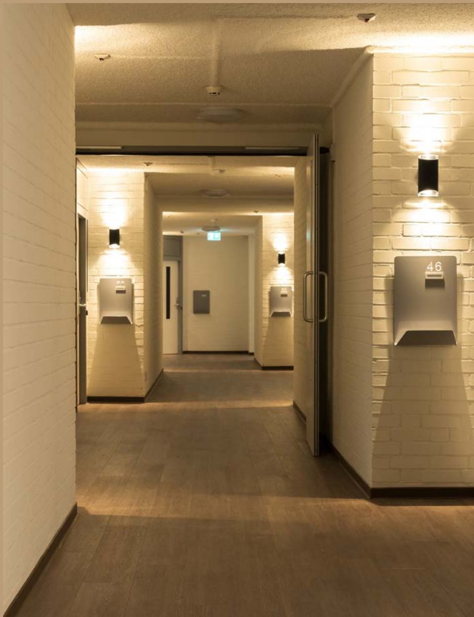
Corridor met pvc vloerafwerking, gesausde wanden, met akoestisch spuitwerk afgewerkt plafond en nieuwe led-verlichting.
