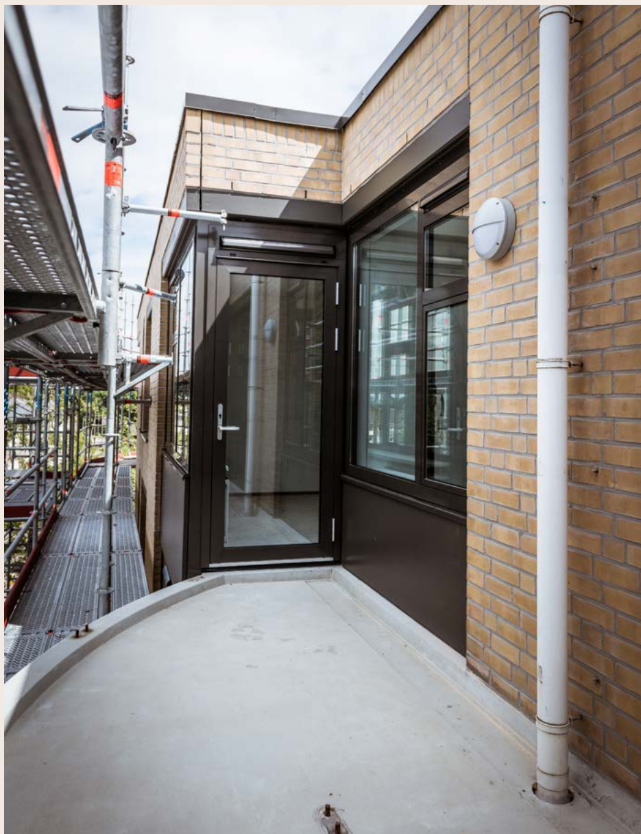
Nieuwe aluminium gevelkozijnen.
