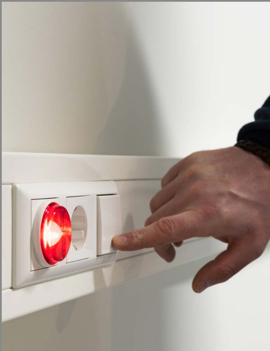
Laadpunt scootmobielen met timer om overbelasting en brandgevaar tegen te gaan.
