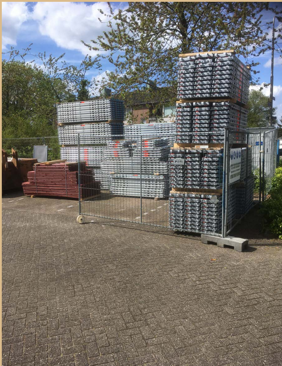
Start opbouw gevelsteigerwerk.
