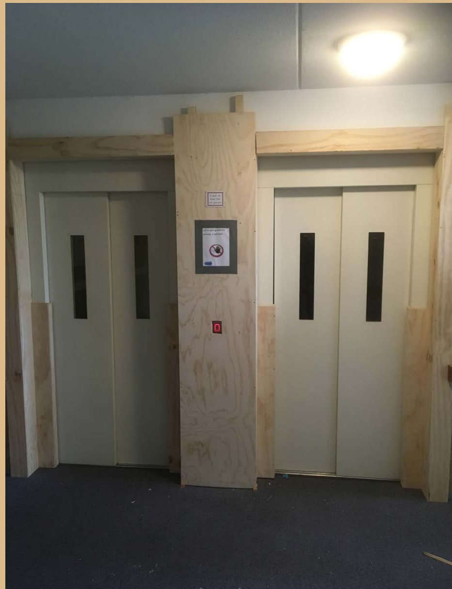
Bescherming liften voor bouwwerkzaamheden.
