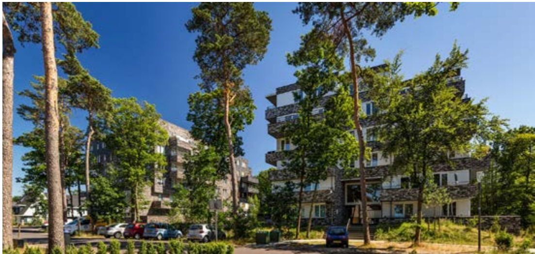
gebouwen zorgvuldig ingepast tussen bestaande bomen
