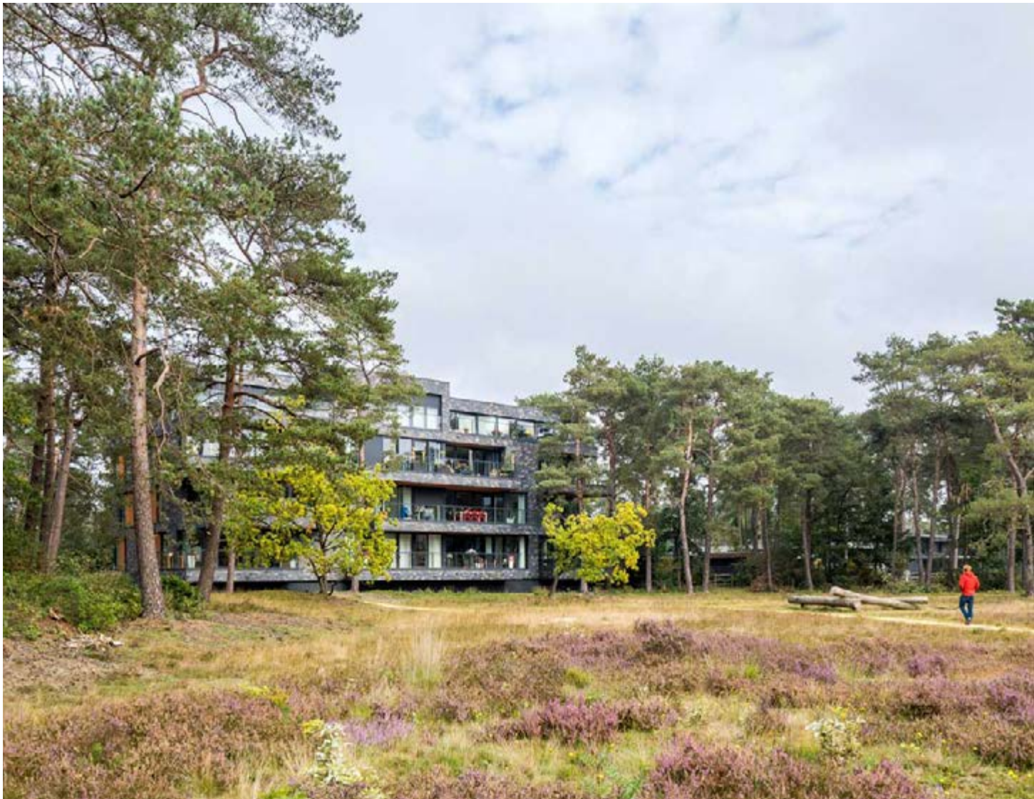
Zachte overgangen tussen buitenruimte en gebouwen
