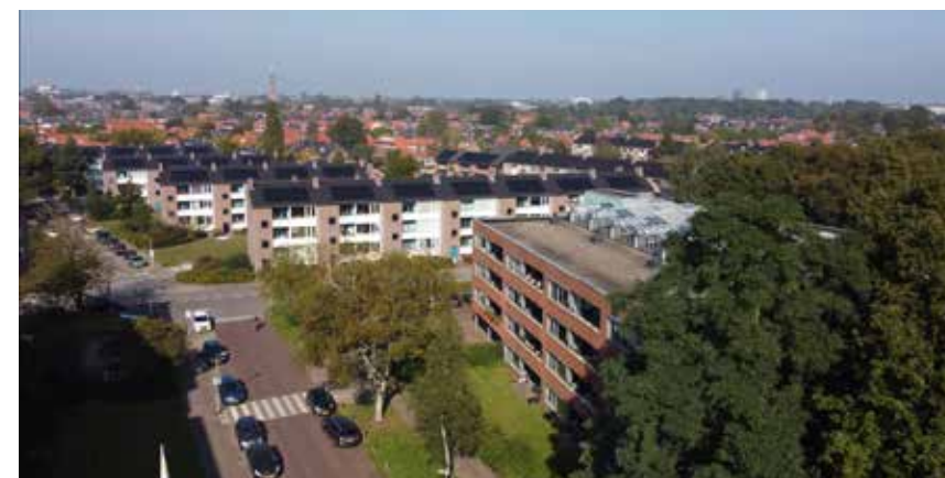
Dronebeeld op de hoek van gebouw B op 27m hoogte (10e verdieping) kijkend naar de Bosrand
