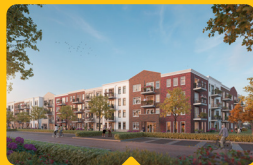
Start nieuwbouw De Hoge Cingel, Zaltbommel
