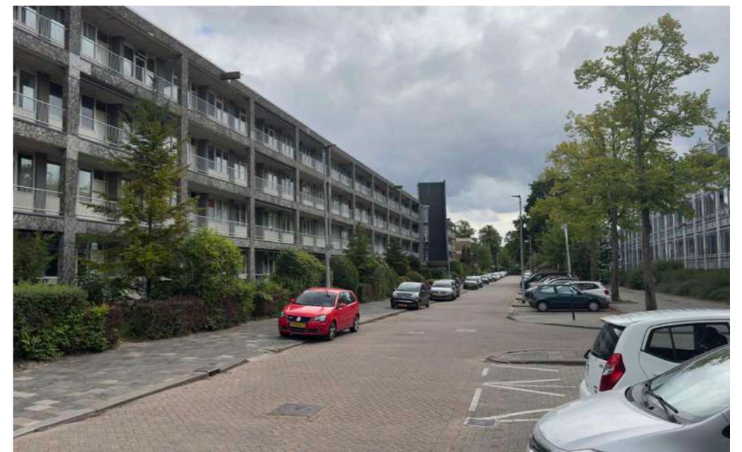
04 | Bestaande grid gevel met galerij & auto's parkeren op de stoep.
