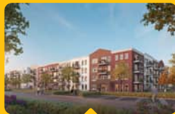
Start nieuwbouw De Hoge Cingel, Zaltbommel
