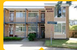
Renovatie De Vijverhof (Delft) en De Hogekamp (Epe) gereed
